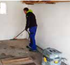
Curățați fisurile din beton și aspirați suprafața
