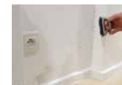
Lăsați să se usuce cel puțin 24 ore și îndepărtați matricea cu o perie
