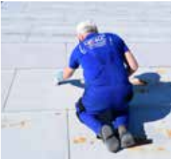
Suprafața tratată după aplicarea stratului anticoroziv
