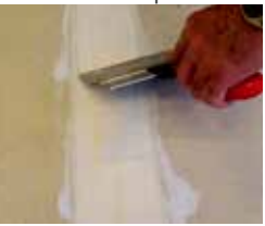
Se aplică pe suprafața dorită. Se usucaă aproximativ 4 ore la 20 °C
