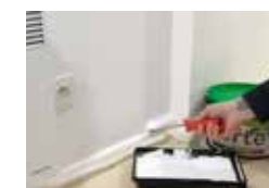
Aplicați al doilea strat și lăsați la uscat.
