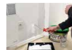
Aplicați primul strat. Timpul de uscare dintre straturi este de aproximativ 24 ore
