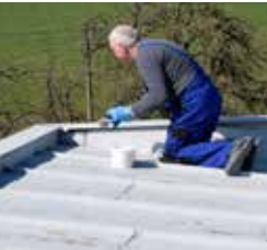
Acoperiți zonele afectate de coroziune cu vopsea anticorozivă
