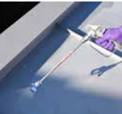
Pulverizați cu echipament de pulverizare de înaltă presiune 2 straturi
