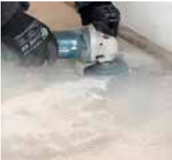
După uscare șlefuiți suprafața cu un șlefuitor vibrat sau unghiular
