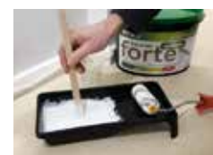
Amestecați INTERIER FORTE ANTIBAC, se diluează primul strat cu aproximativ 10-20 % apă
