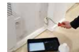
Aplicați penetrarea pe perete și lăsați să se usuce cel puțin 8 ore
