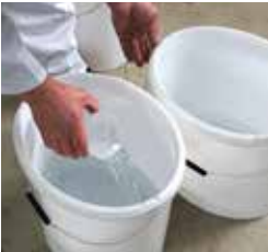
Turnați apă în recipient și adăugați pulberea: 4,4–4,75 l / 25 kg, ROKOPLAN PROFI: 4,4–4,6 l / 25 kg)
