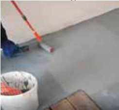
Acoperirea finală a podelei după tehnica acoperirii încrucișată
