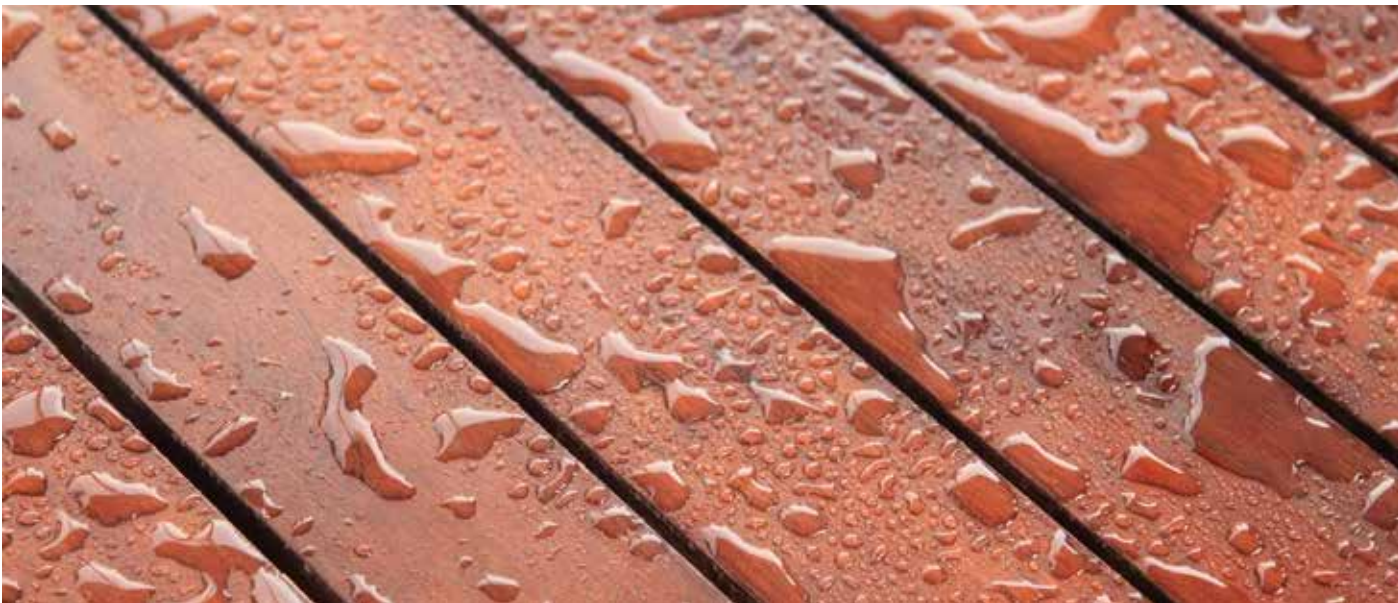
Spălați suprafața cu apă, repetați în caz de albire puternică
