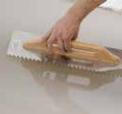
Nivelați stratul aplicat
