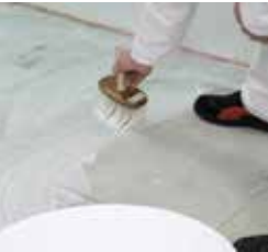
Grunduiți suprafața (ROKOGRUND PROFI+ROKOLATEX sau penetrare EP umplută cu nisip siliciu)
