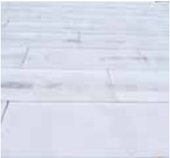
Uscarea stratului anticoroziv 4-5 ore
