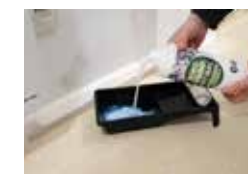
Pregătiți penetrarea antifungică ROKOGRUND ANTIBAC care este nediluată
