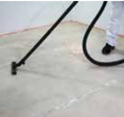
Măturați și aspirați substratul
