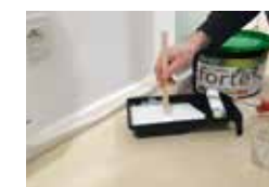
Diluati vopseaua interioară pentru al doilea strat cu aproximativ 5-10 % apă
