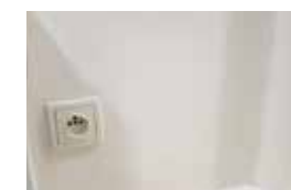
Suprafață finală după aplicarea ROKOANTIBAC SYSTEM care protejează zidăria de acțiunea microorganismelor
